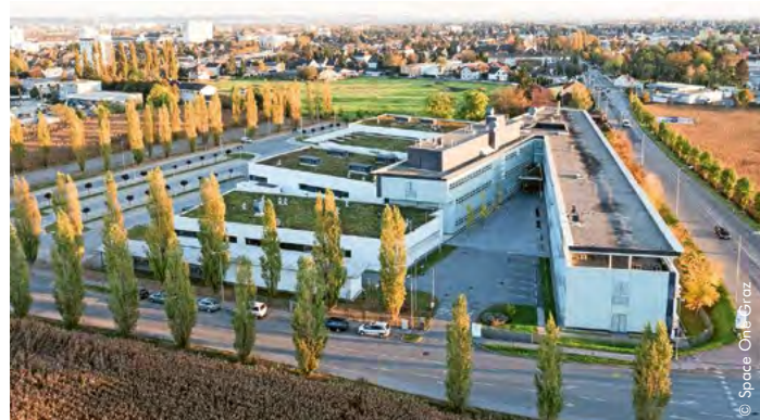
Das Technologiezentrum Space One in Graz wurde von GalCap Europe für ein deutsches Versorgungswerk erworben.
