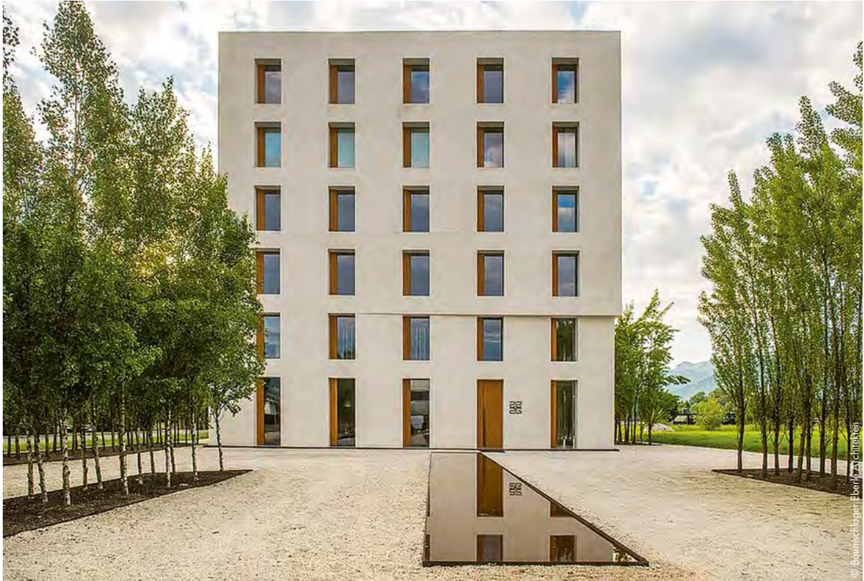
Ohne Heizung, Kühlung und Lüftung: Das Bürohaus 2226 im vorarlbergischen Lustenau
